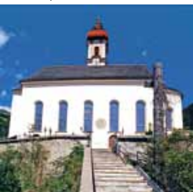
Chiesa parrocchiale di Colle Isarco
